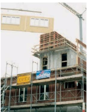
Die Ilge besteht aus vorgefertigten Holzelementen
